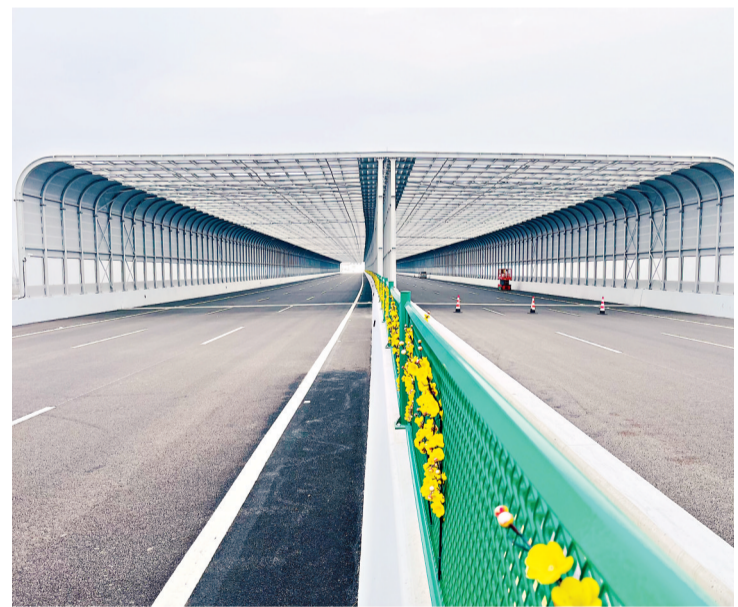
3月19日,双柳长江大桥400米长的全封闭声屏障。
