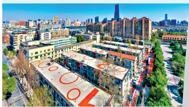
改造后的江岸区惠济路42号小区。
