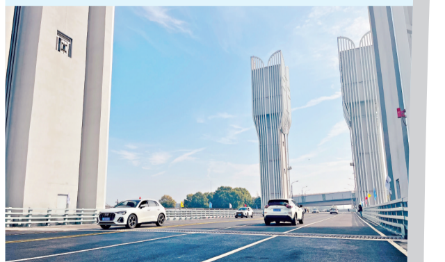
右岸大道开启桥现场。
