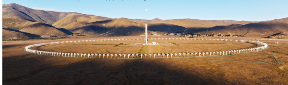
位于四川稻城的子午工程二期大型监测设备之圆环阵太阳射电成像望远镜(2024年9月19日摄,无人机照片)。
