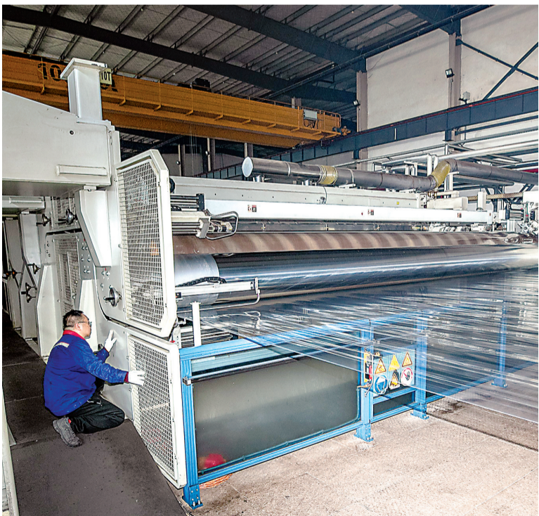
值班技术人员巡查薄膜生产线。
